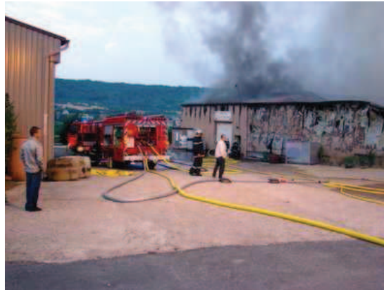
Le hangar de tôle de 1 200 m2 a fondu comme neige au soleil.
